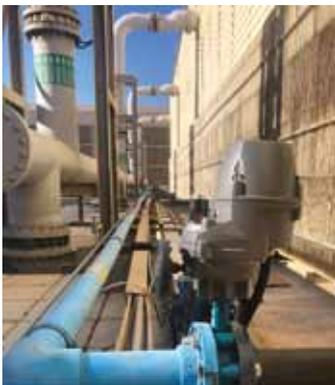
Der PROFOX im Einsatz in einer Fernkälteanlage. Der elektrische Stellantrieb ermöglicht höchste Flexibilität, kurze Lieferzeiten und ein einheitliches Bedienkonzept über alle Gerätetypen hinweg. Foto: AUMA
