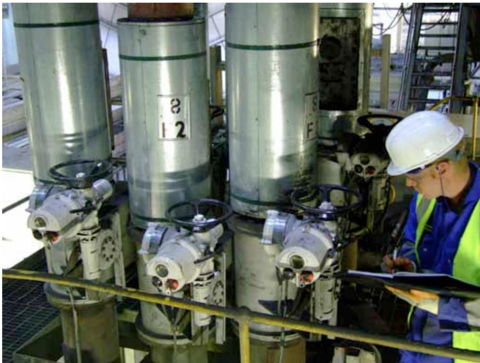
Rotork elektrische Antriebe vom Typ IQ, eingebaut an einer Abgasklappe in der rauen Umgebung eines Kraftwerks.
