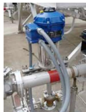
Im Bild ein elektrischer Antrieb für ein Regelventil – vom Typ CVA – im Ozoneinsatz bei einer Abwasserbehandlungsanlage in den USA.
