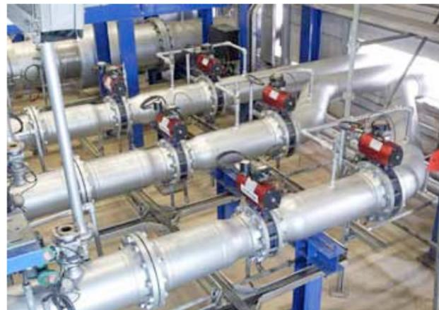
Im EuroLoop wurden Rotork pneumatische Antriebe RC200 installiert. Bei EuroLoop handelt es sich um die weltgrößte Anlage für Durchflussmesskalibrierung.
