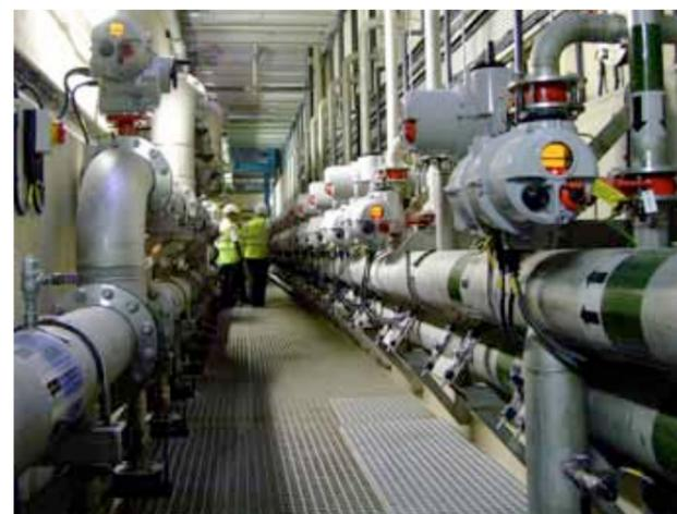
Rotorks elektrischer Antrieb IQT steuert eine Membranfiltrationsanlage in einem Klärwerk.
