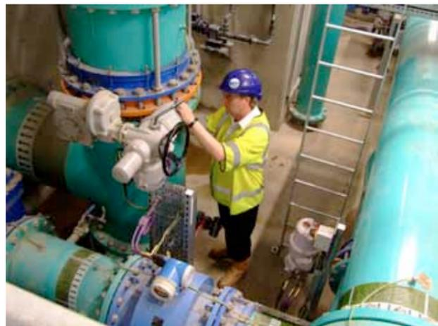
Die elektrischen Antriebe des Typs IQ steuern den Automatikbetrieb einer Filtrationsanlage in einem großen Wasserwerk.
