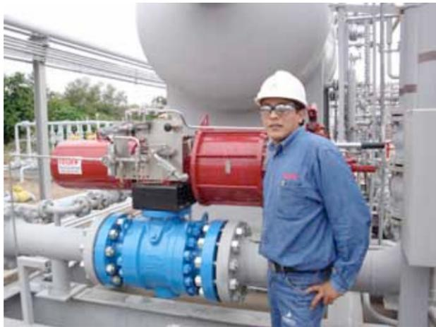
Die SIL2 zertifizierten pneumatischen Antriebe des Typs GP an Notabschaltungsarmaturen in einer Erdgasanlage in Bolivien.
